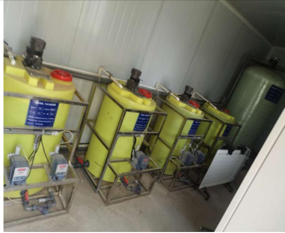
药研院 09 地块现状地下一体化污水处理设备及加药间 图 22 药研院 09 地块现状地下一体化污水处理设施情况
